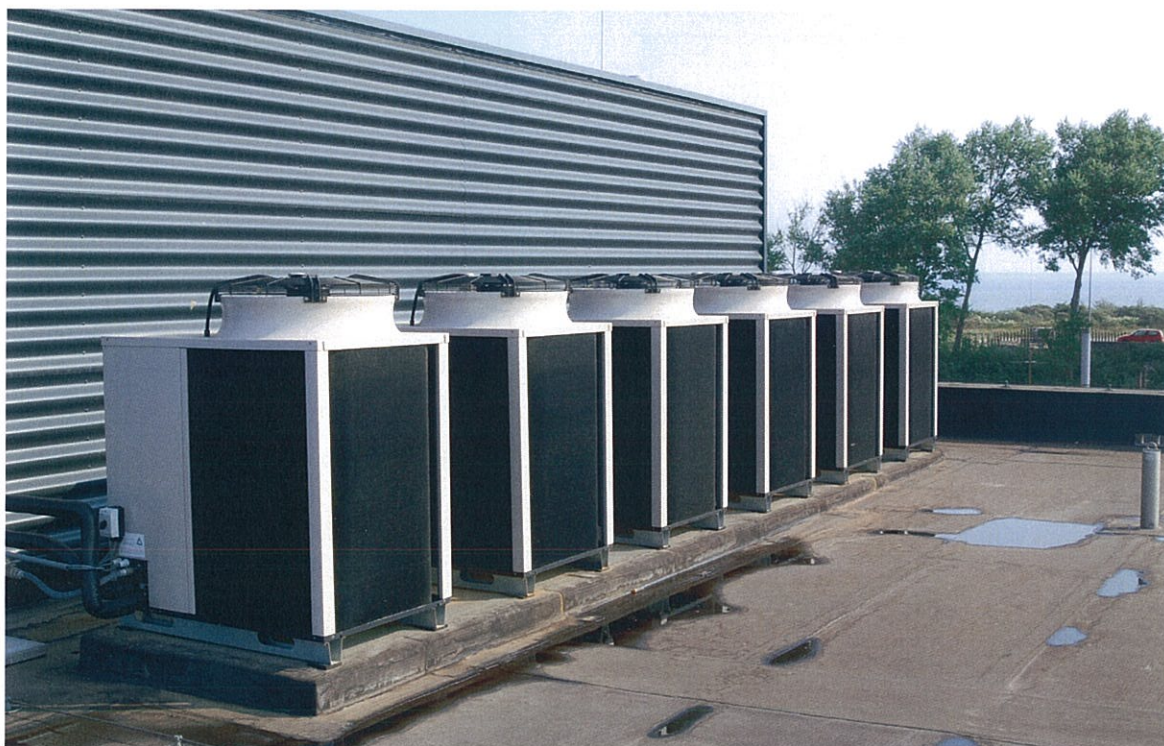
Op het dak van een woongebouw, zorginstelling of hotel kan probleemloos een aantal warmtepomptoestellen worden geplaatst, mits de dakconstructie daarop is berekend.
